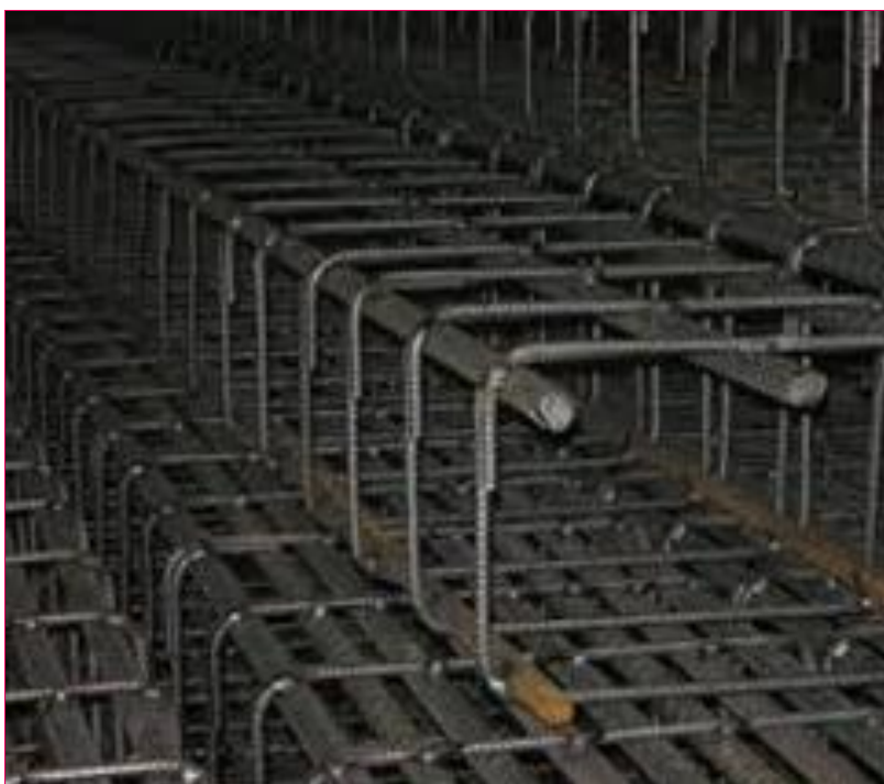
ნახ.20. შედუღებული სივრცითი კარკასი სვეტის ელემენტისათვის
