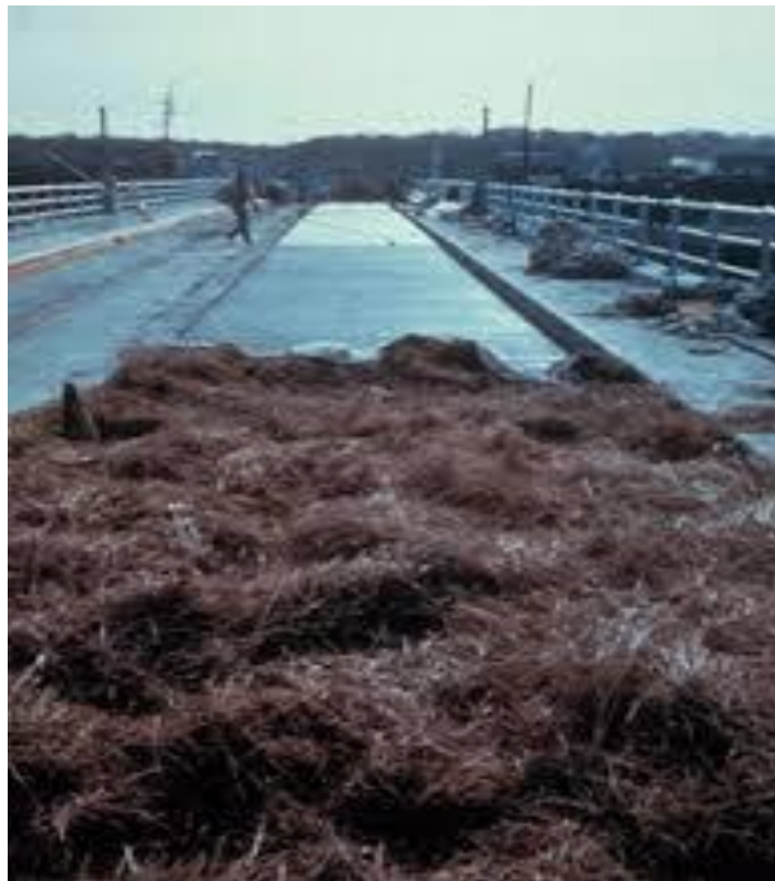
ბეტონის ნარევის შეფუთვა თივით
