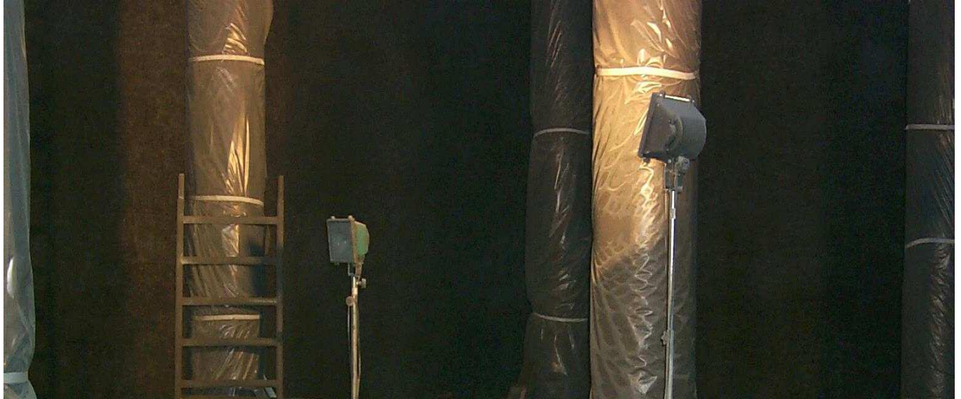
ბეტონის მოვლა უარყოფით ტემპერატურულ პირობებში თბოგამომსხივებელი ნათურებით
