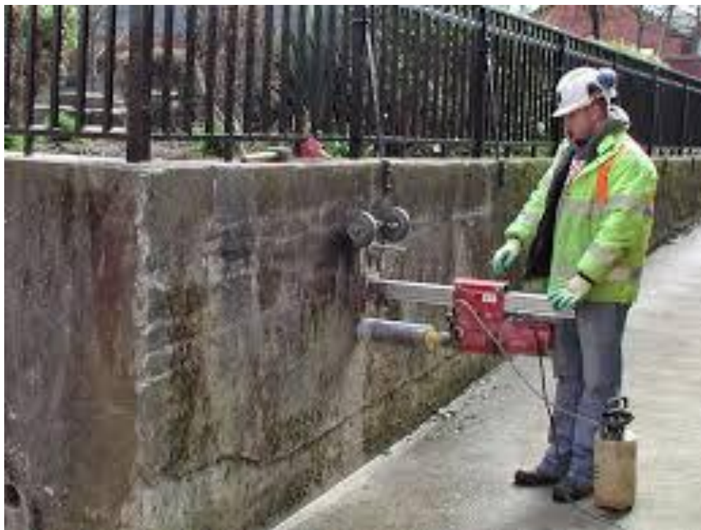
ბეტონის კონსტრუქციიდან კერნის ამოჭრა
