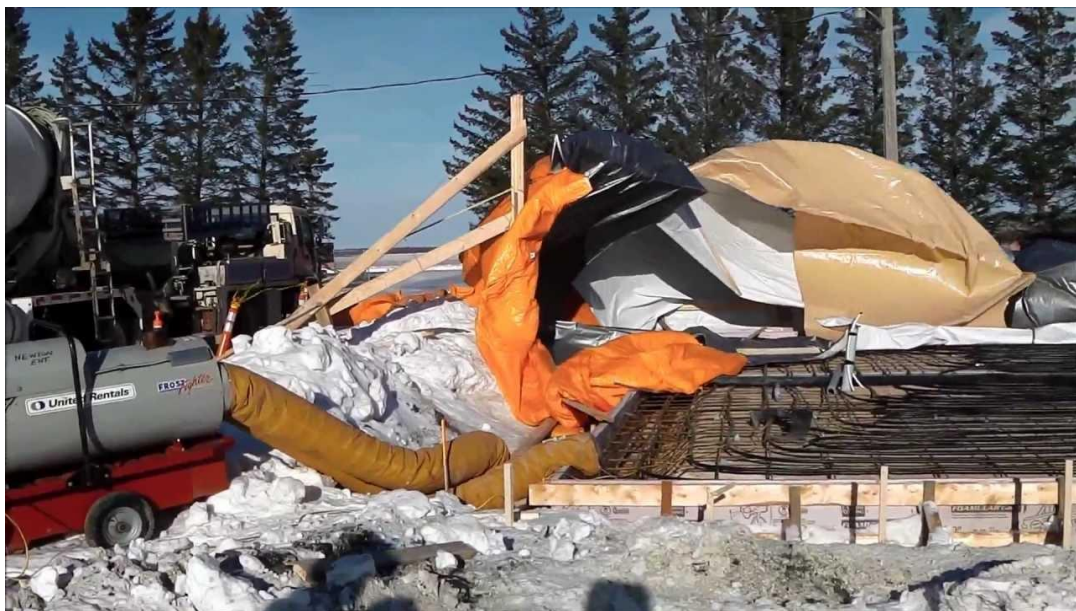
ბეტონის ჩასხმა ზამთრის პირობებში
