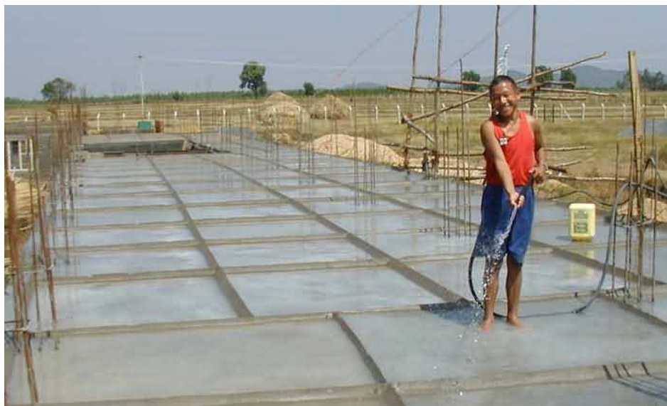
ბეტონის ფილის მორწყვა ზაფხულის პირობებში
