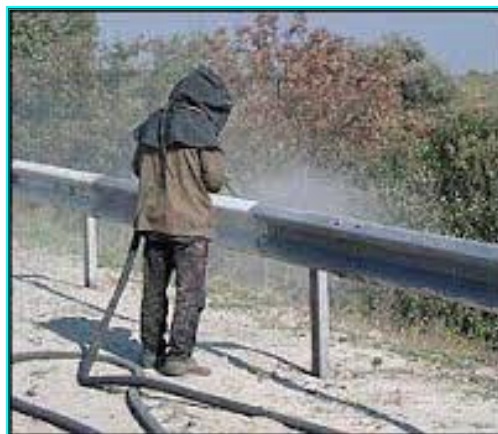
ნახ. 25. ლითონის ზედაპირის დამუშავება ანტიკოროზიული ხსნარით
