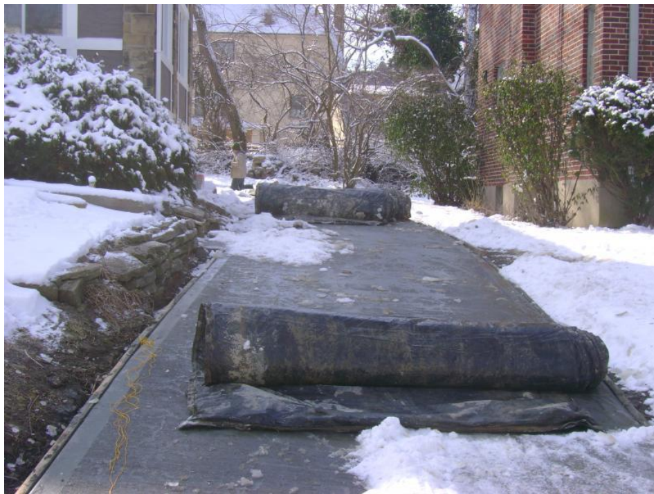
ბეტონის ნარევის შეფუთვა რუბეროიდით
