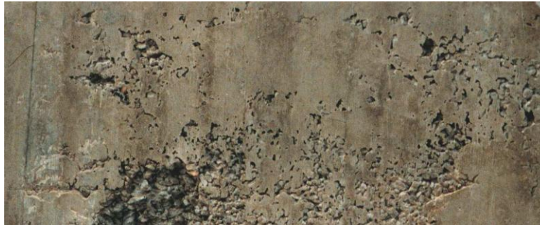
ბეტონის არასწორი ვიბრირებით გამოწვეული ხარვეზი
