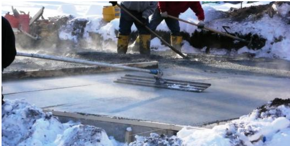
ვიბრო-რელსის ამძრავით ბეტონის მოსწორება ზამთრის პირობებში
