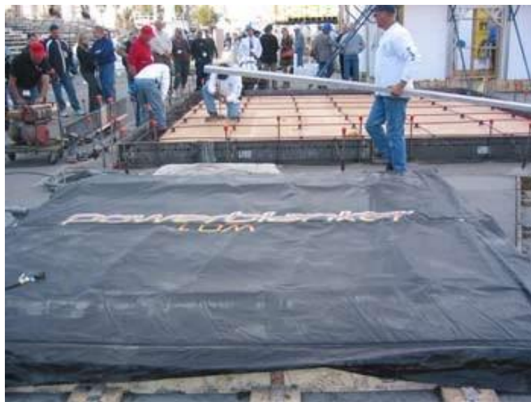
ბეტონის ნარევის შეფუთვა ჰერმეტიული დამათბუნებლით (ბრეზენტი)
