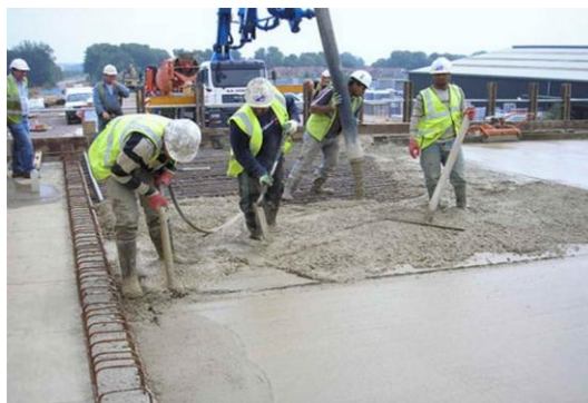
ყალიბში ჩასხმული ბეტონის ნარევის მოსწორება
