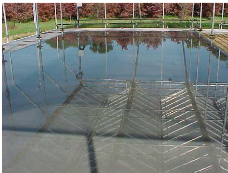
ბეტონის ფილის მოვლა ზაფხულის პირობებში
