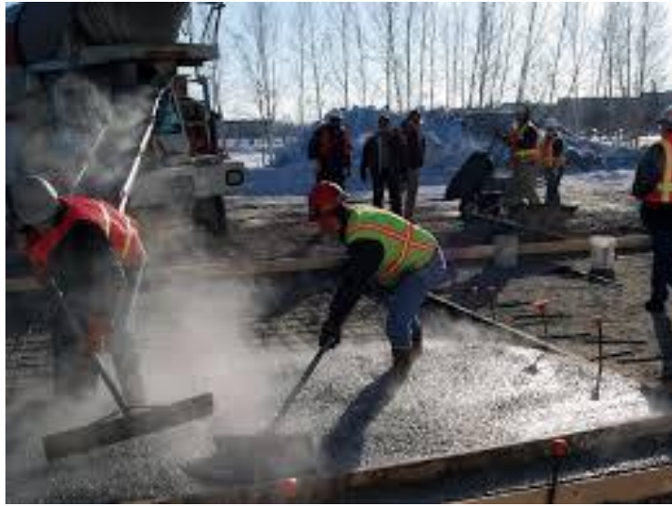
წინასწარ გახურებული მასალებით მომზადებული ბეტონის ნარევის ჩასხმა ზამთრის პირობებში
