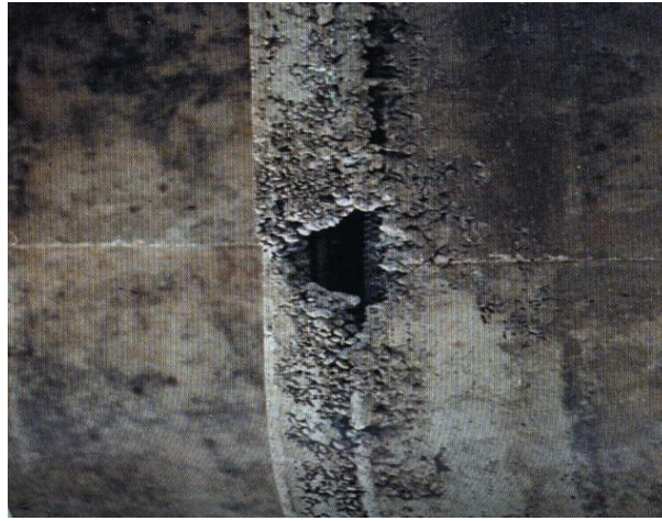
ბეტონის არასწორი ვიბრირებით გამოწვეული ხარვეზი
