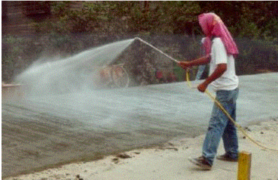
ბეტონის ფილის მორწყვა ზაფხულის პირობებში
